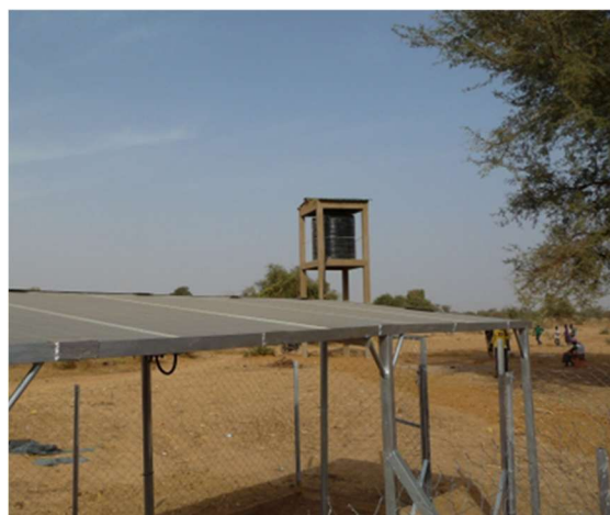
Solar betriebene Brunnenanlage für Trinkwasser
